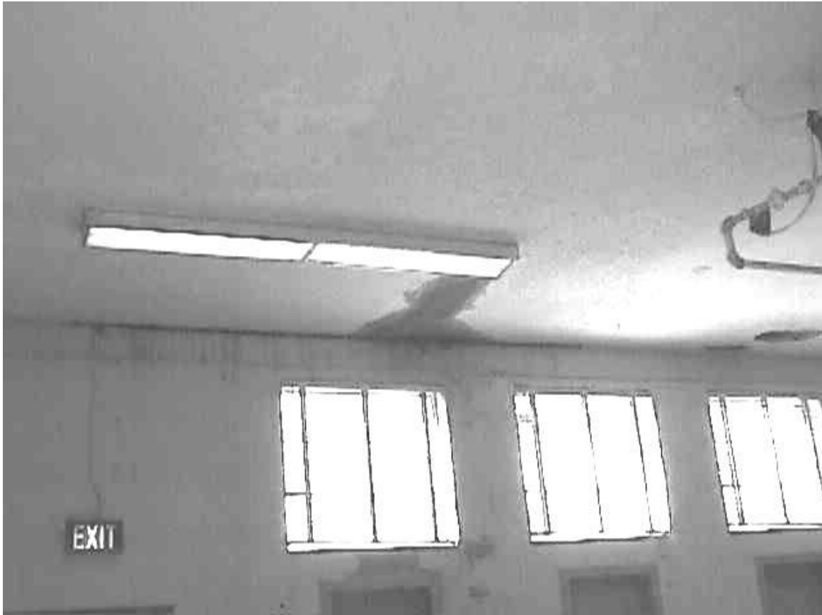
F. R. Danyus Head Start Center Cafeteria Ceiling
